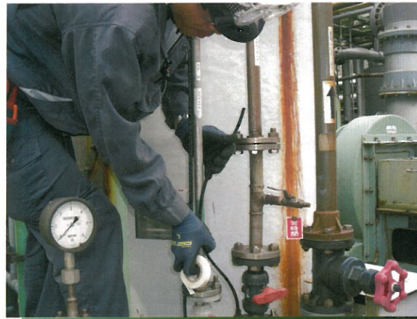
オートトレースヒータ施工例
