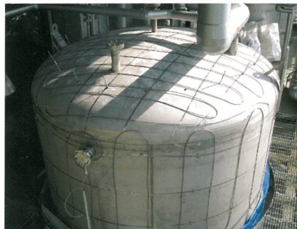
MIヒータ施工例
